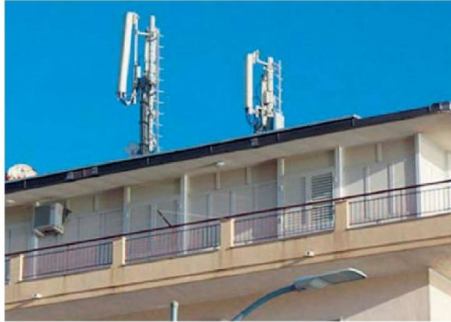
Sui tetti Antenne telefoniche in un'immagine d'archivio
