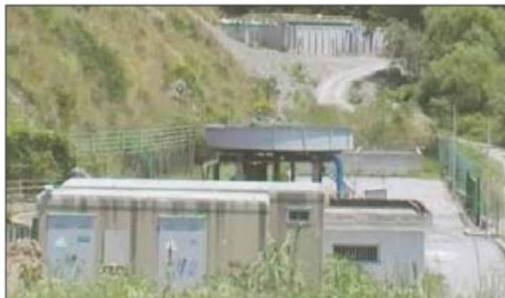
L'impianto di depurazione di San Lucido
