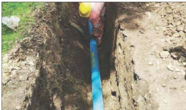
Lavori alla condotta idrica Stramerca
