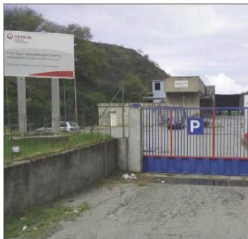
L'impianto di Sambatello
