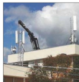
L'installazione delle antenne
