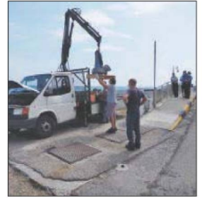
L'intervento di riparazione
