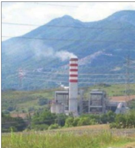
La centrale del Mercure
