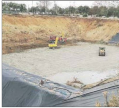
Automezzi durante i lavori alla discarica
