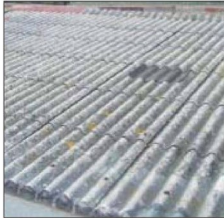
Un tetto in amianto
