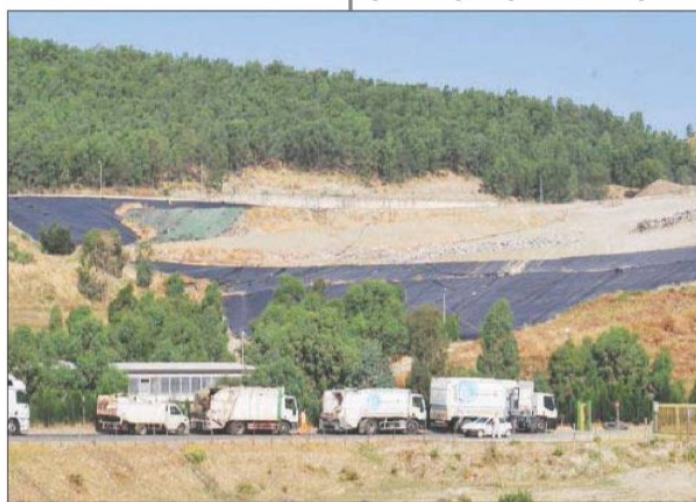
L'ingresso all'impianto di Alli in una foto di repertorio
