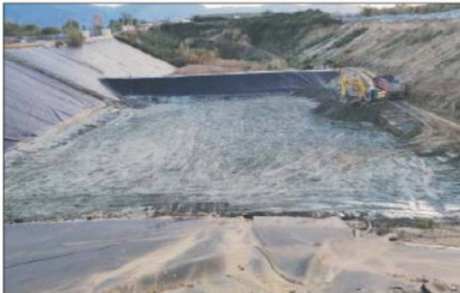
I lavori all'interno della discarica La Zingara di Melicucco
