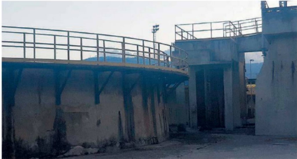
Il depuratore Il vecchio impianto, al confine tra Soverato e Satriano, che sarà abbandonato
