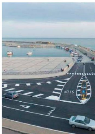
Infrastruttura Il porto di Lido attende di essere completato
