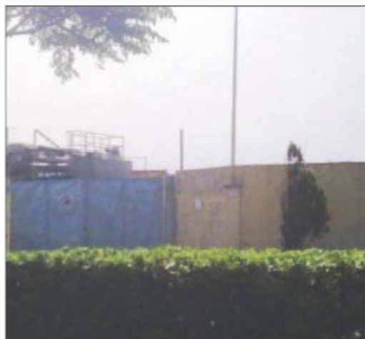
Il depuratore comunale
