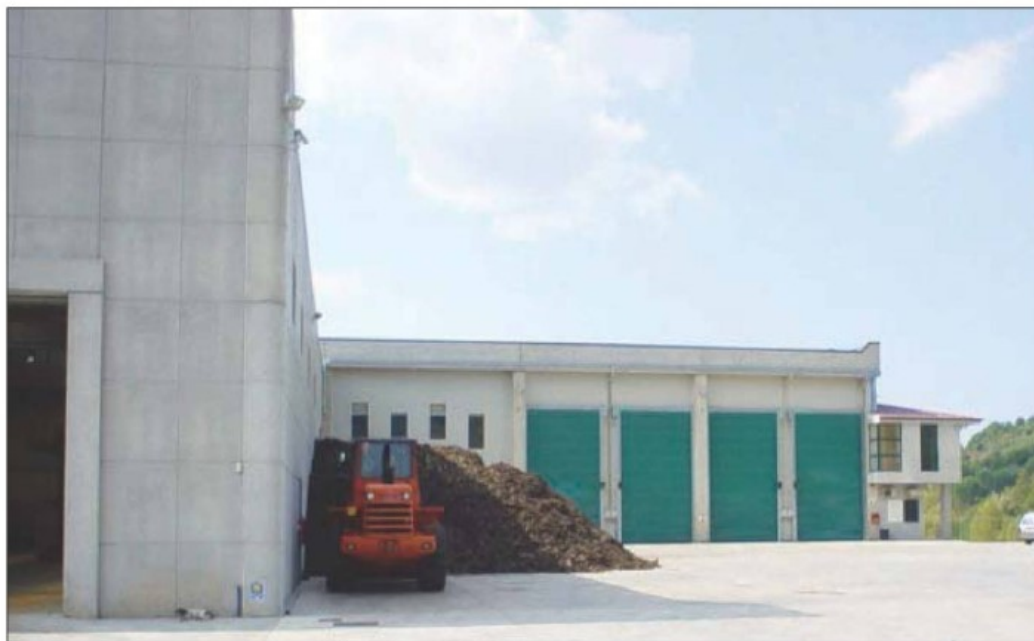
L'impianto di compostaggio di Vazzano (Vv) gestito dalla Eco Call
