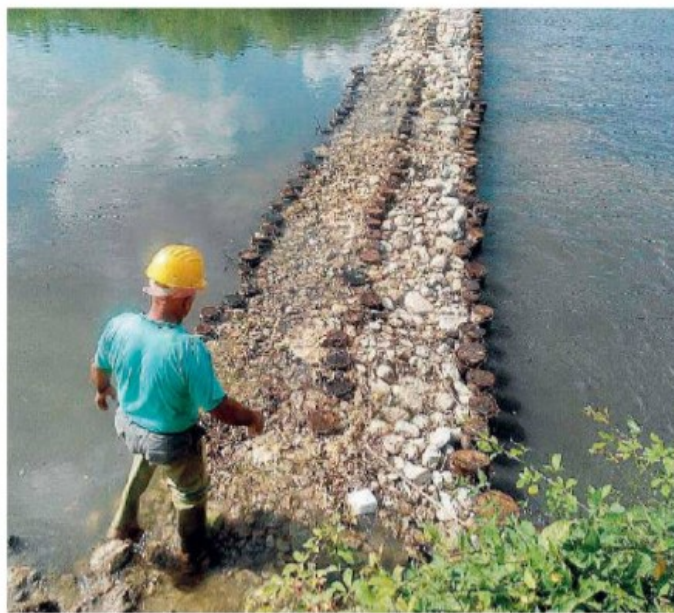
La barriera Una struttura temporanea per il contenimento dei liquami
