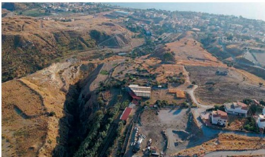
Nel mirino La comunità sperava di essere ripagata con la messa in sicurezza e la bonifica del sito
