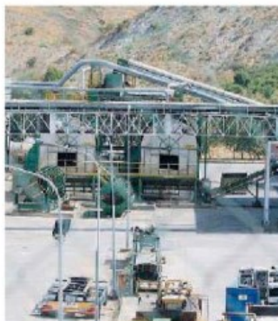
Impianto La discarica di Alli che sorge nel Catanzarese
