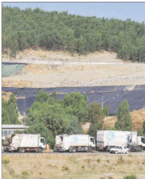
L'area della vecchia discarica di servizio di Alli
