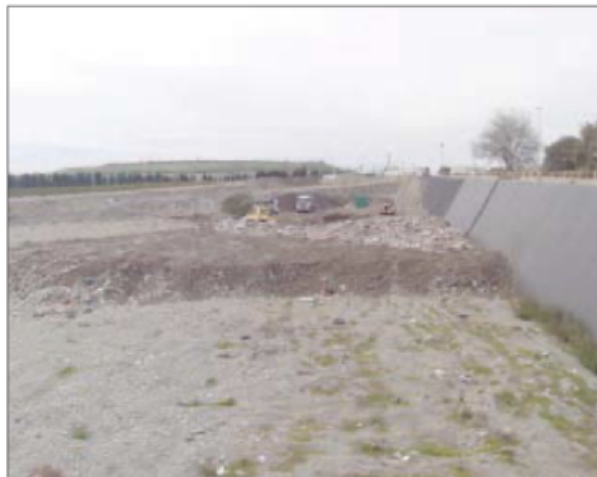
La discarica di località Stretto
