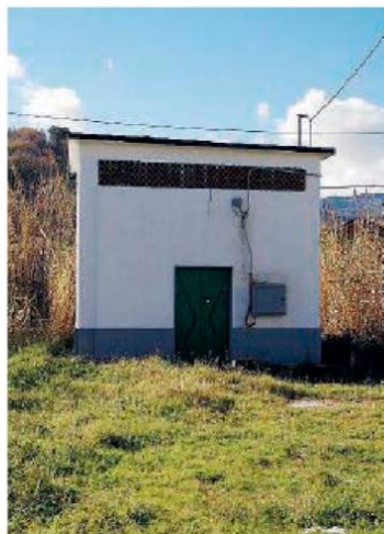
Problemi L'acquedotto di San Vito situato in via Roma
