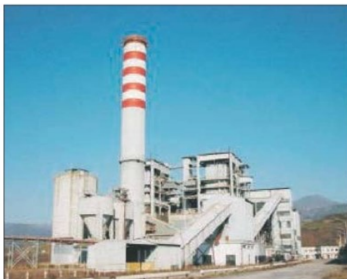
La centrale del Mercure
