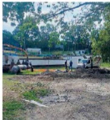
Lavori La sostituzione delle condotte richiederà due settimane
