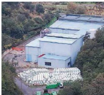
L'impianto Riveste un ruolo strategico nella filiera dei rifiuti
