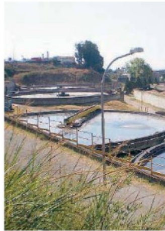
Stipati Idrocarburi e olii esausti sono rimasti nel depuratore
