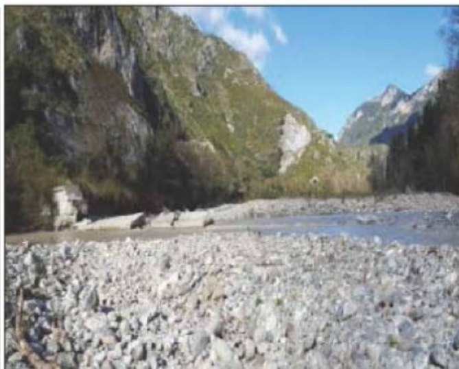
Il luogo individuato per le nuove centraline elettriche sul Noce
