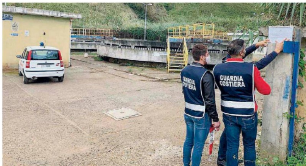
Operazione "Water clean" Militari della Guardia costiera mentre appongono i sigilli all'impianto di località Marinella
