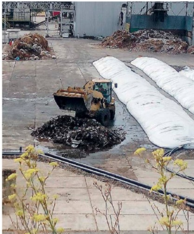
L'impianto La struttura di trattamento di Alli sarà radicalmente modificata
