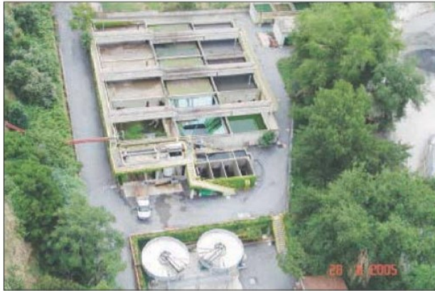
Una veduta aerea dell'impianto di depurazione di Fuscaldo marina
