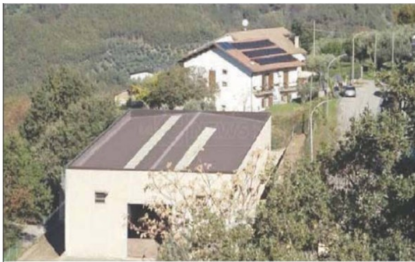
Il capannone dell'impianto di stoccaggio rifiuti
