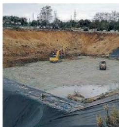
«La Zingara» Riprendono i lavori nella discarica di Melicucca
