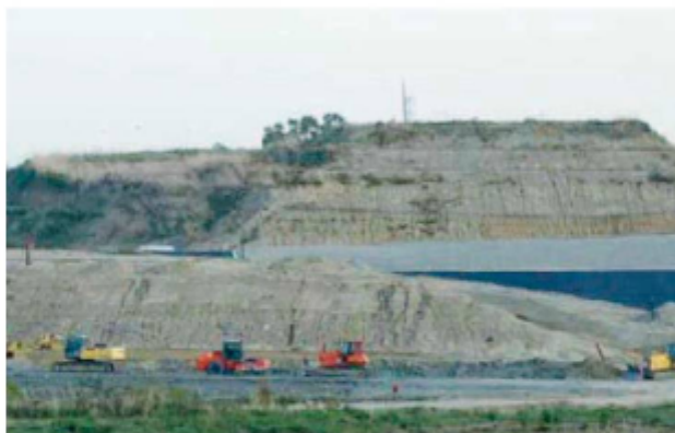
L'impianto La discarica di Columbra accoglie i rifiuti provenienti da mezza Calabria
