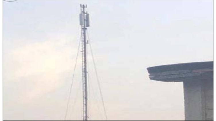
L'antenna di telefonia "5G" abusiva installata in un terreno di proprietà privata
