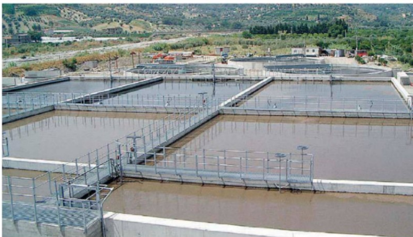
Depuratore L'impianto sidernese resta al centro del progetto regionale
