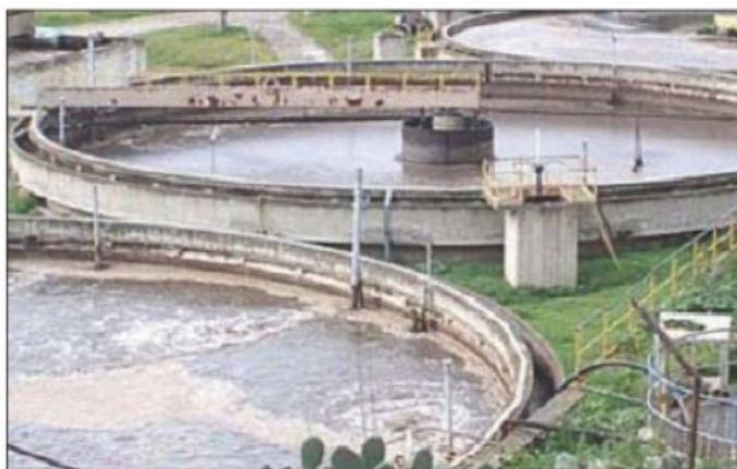
Le vasche dell'impianto consortile di Siderno
