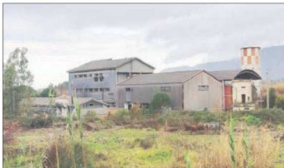
L'ex complesso industriale in località Bellafemmina
