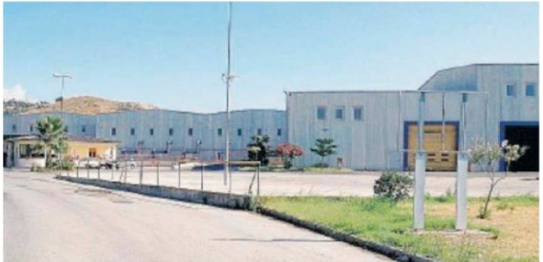
Contrada San Leo L'impianto di trattamento rifiuti a Siderno
