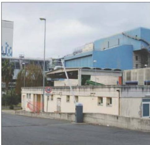
Il termovalorizzatore di Gioia Tauro
