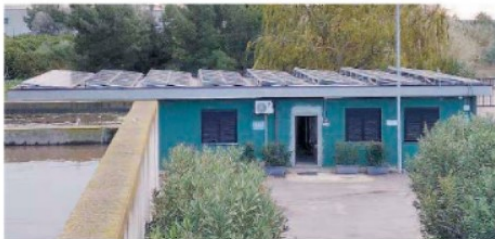
Gli uffici Dotati di tetto con impianto fotovoltaico
