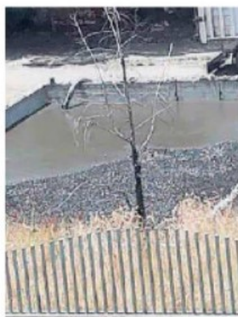
Problemi Una delle vasche del depuratore di Ravagnese a Reggio
