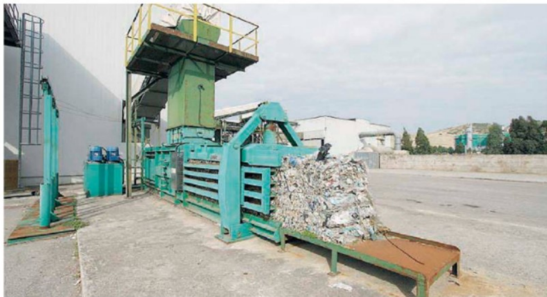
Procedimenti Uno degli impianti per il trattamento dei rifiuti all'interno della discarica di Alli a Catanzaro
