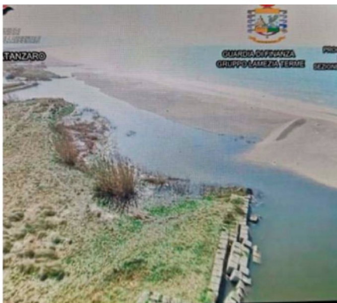
Disastro ambientale La foce del torrente Turrina nell'area industriale
