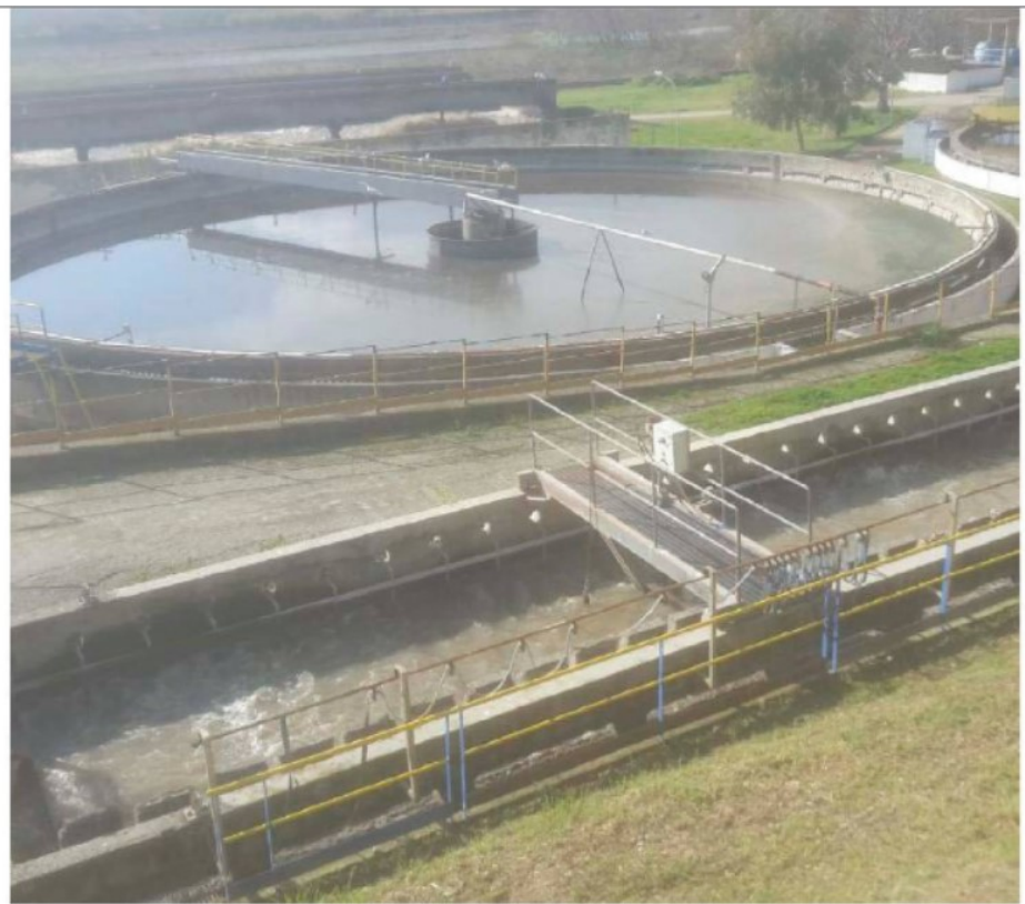
Località Verghello Il depuratore di Catanzaro attende da anni interventi di ammodernamento
