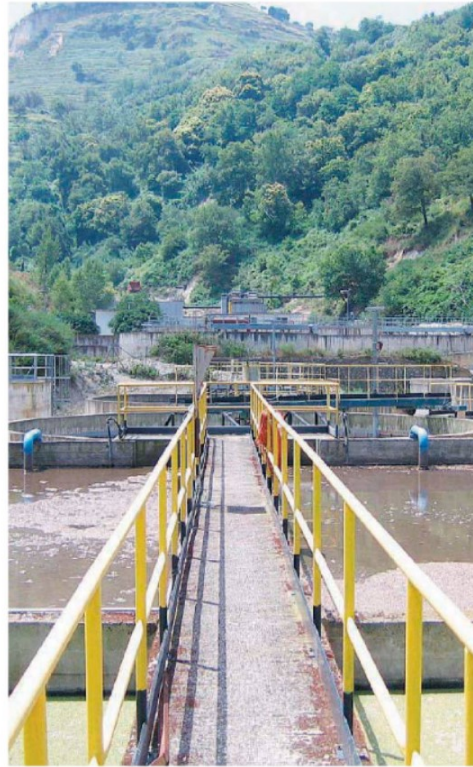
Depuratore Le Grazie L'impianto da sempre sottodimensionato
