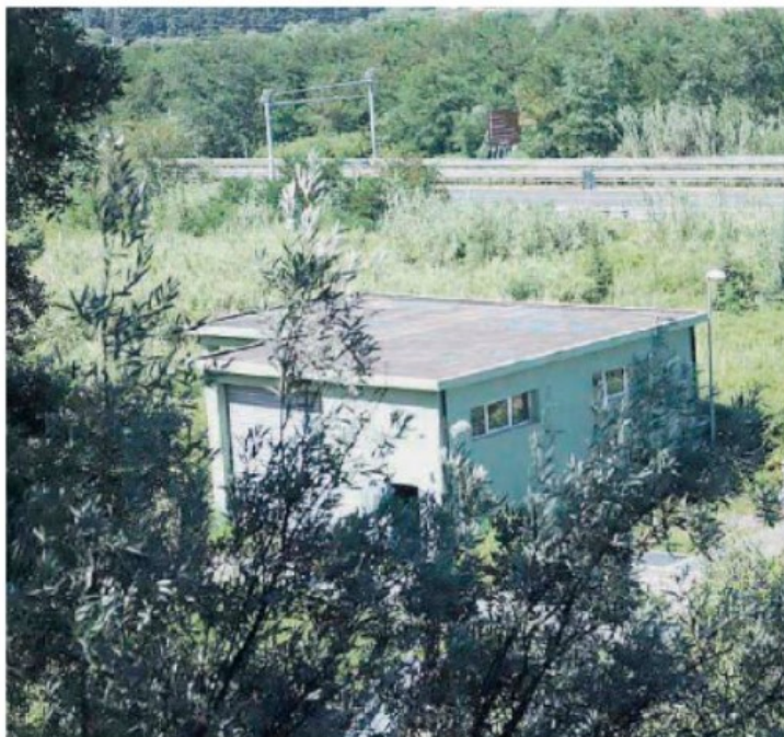
Depuratore di località "Cannalia" Costato oltre tre mln di euro e mai entrato in funzione
