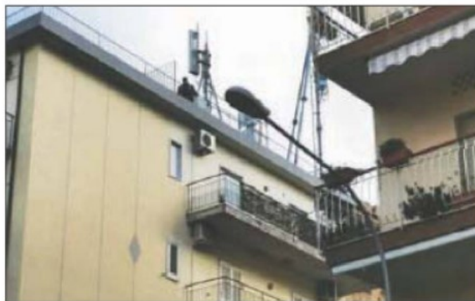
I lavori per l'installazione dell'antenna Iliad in via Rocco La Russa
