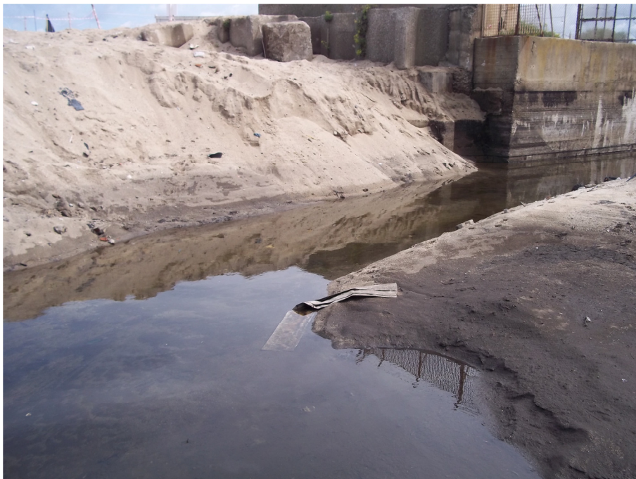
Foto 4- Sopralluogo del 22 settembre 2016
