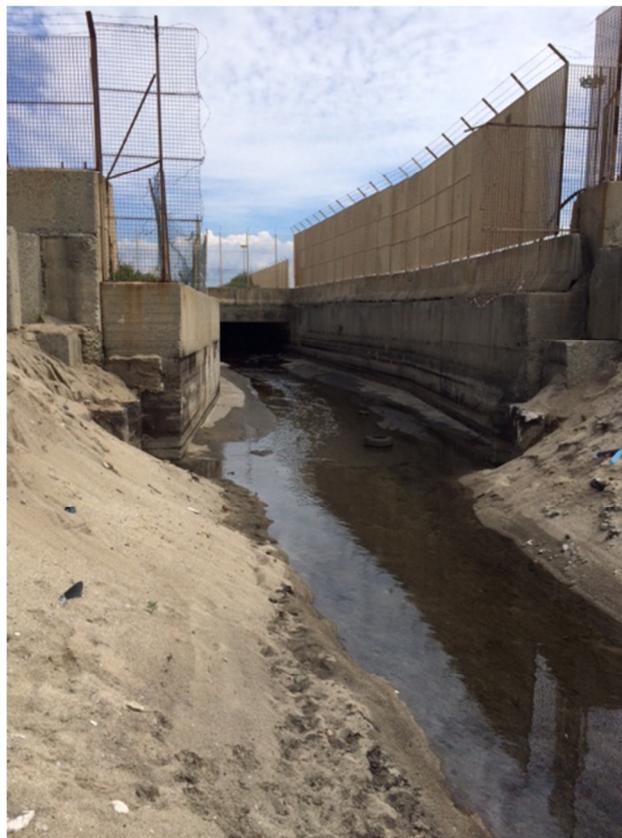
Foto 6 – Sopralluogo del 26 settembre 2016
