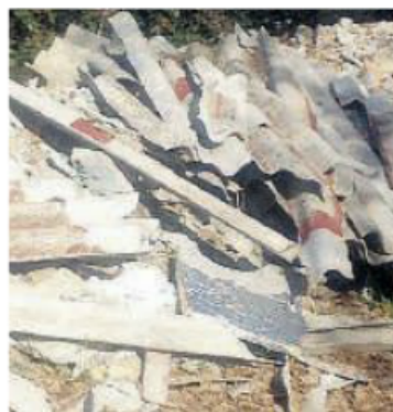
L'eternit rinvenuto sulla strada. Non sono mancate le polemiche
