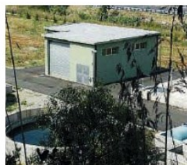
Bivio Angitola. Il depuratore mai entrato in funzione
