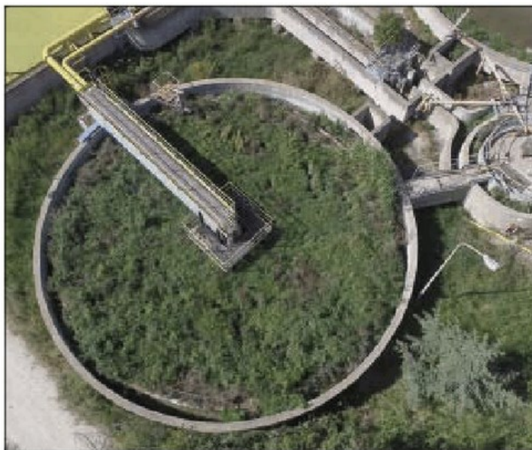
Il depuratore di Crotona
